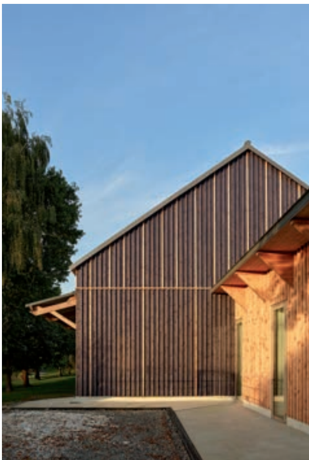
Livré en 2025, le pôle socioculturel de La Chapelle-des-Fougeretz (35) est construit sur le site qui accueille une bâtisse typique du pays rennais. L'extension en structure mixte bois-béton est vêtue d'un bardage en Douglas.
